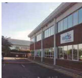
Modernizacja call centre w Woodhouse Environmental Services Ltd. w Bourmemouth, Wielka Brytania. VRF
