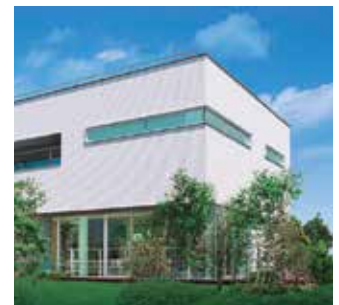
Inteligentny dom na wyspie Ariake w Tokio. Branża ogrzewania, wentylacji i klimatyzacji w połączeniu z solarnym wytwarzaniem mocy, ogniwami aliwowymi i akumulatorami.
