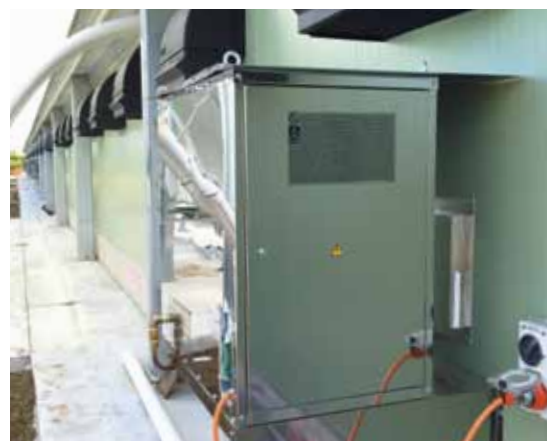
Montaż na zewnątrz
