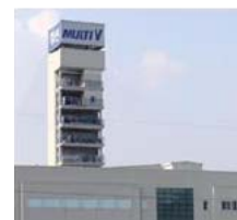
Testy wysokich i długich instalacji
