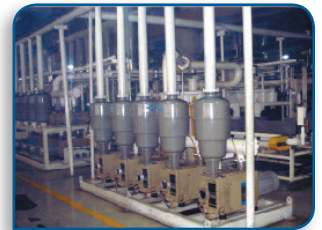
Helowy test szczelności
